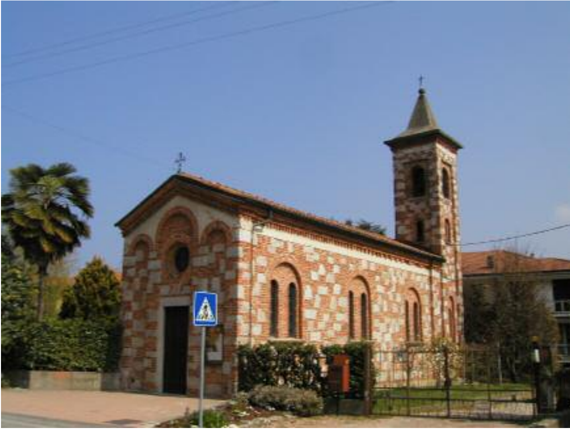
Figura 1 – Veduta della chiesa
