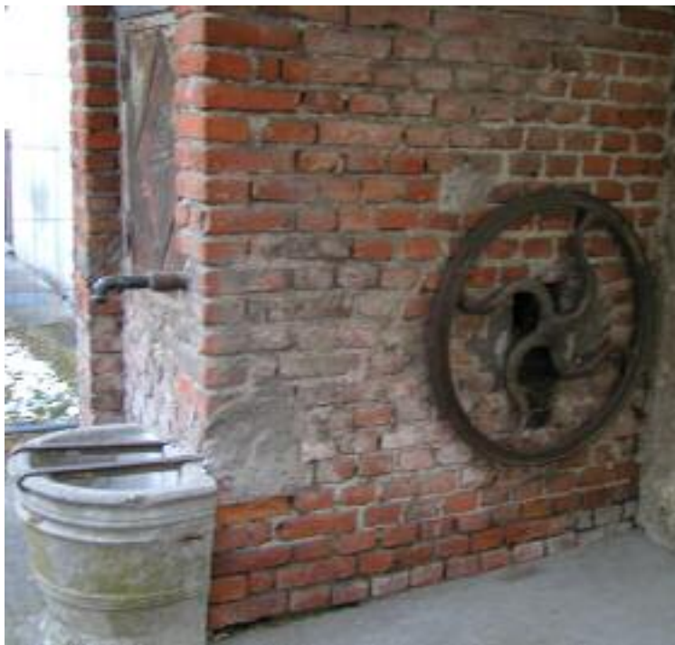
Figura 2 – Via Tripoli, pozzo (particolare)
